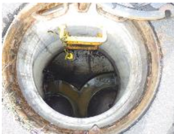
写真 2 硫化水素測定器の設置方法
