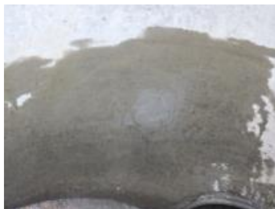
写真 6 採取跡の補修状況
