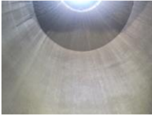
写真 3 マンホール内面状況
