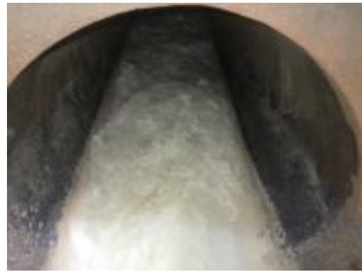
写真 4 管路内面状況
