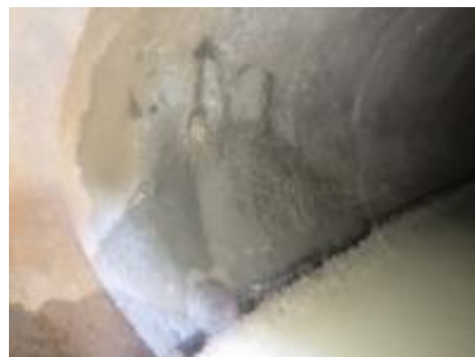
写真 6 採取跡の補修状況
