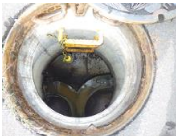
写真 2 硫化水素測定器の設置方法(例)
