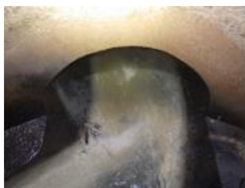
写真 4 管路内面状況
