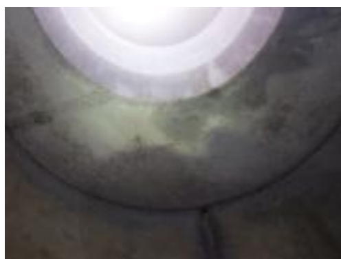
写真 3 マンホール内面状況
