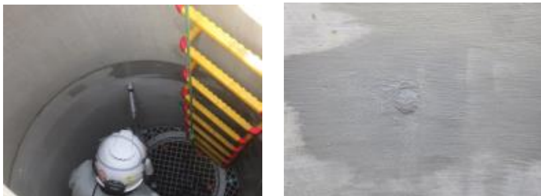
写真 5 コア供試体の採取状況
