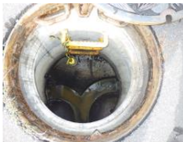
写真 2 硫化水素測定器の設置方法
