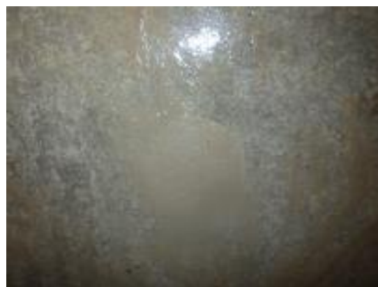
写真 6 採取跡の補修状況
