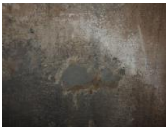
写真 6 採取跡の補修状況
