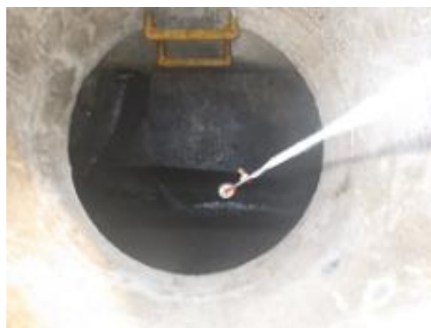
写真 2 硫化水素測定器の設置方法
