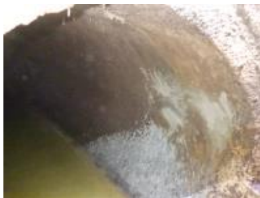
写真 6 採取跡の補修状況
