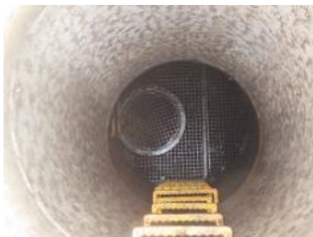
写真 2 硫化水素測定器の設置方法
