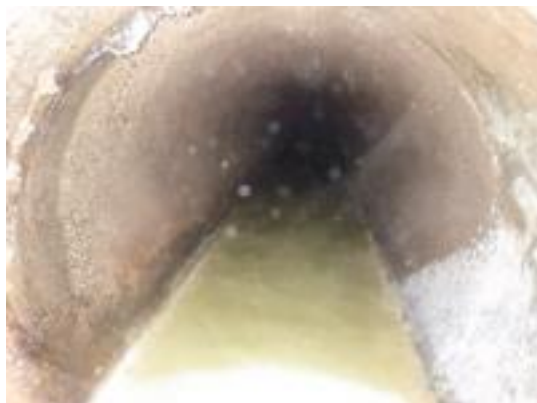
写真 3 管頂部分の内面状況 (その 1)
