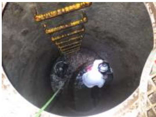
写真 5 コア供試体の採取状況
