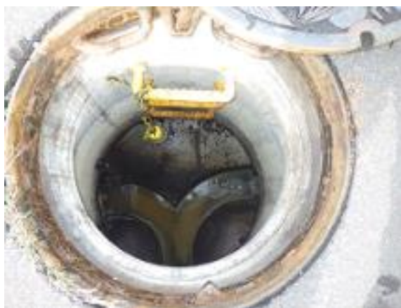
写真 2 硫化水素測定器の設置方法(例)
