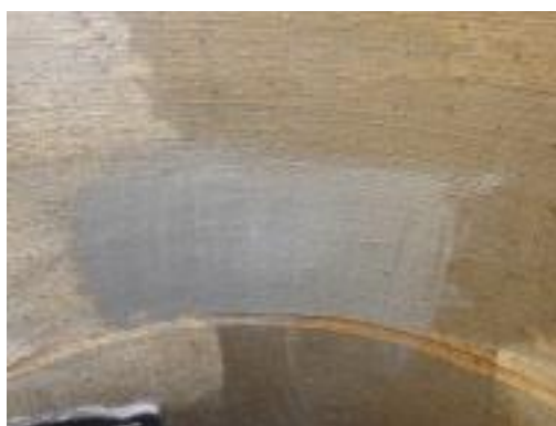
写真 6 採取跡の補修状況
