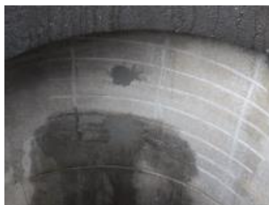
写真 6 採取跡の補修状況
