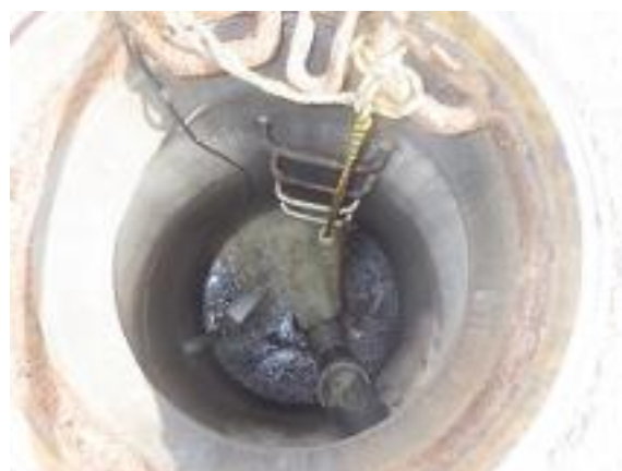
写真 2 硫化水素測定器の設置方法
