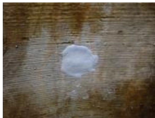
写真 6 採取跡の補修状況
