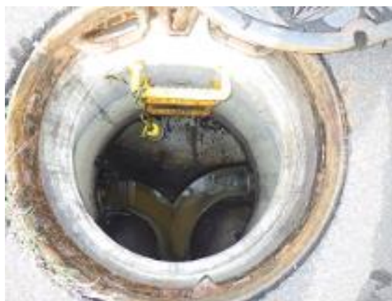
写真 2 硫化水素測定器の設置方法(例)
