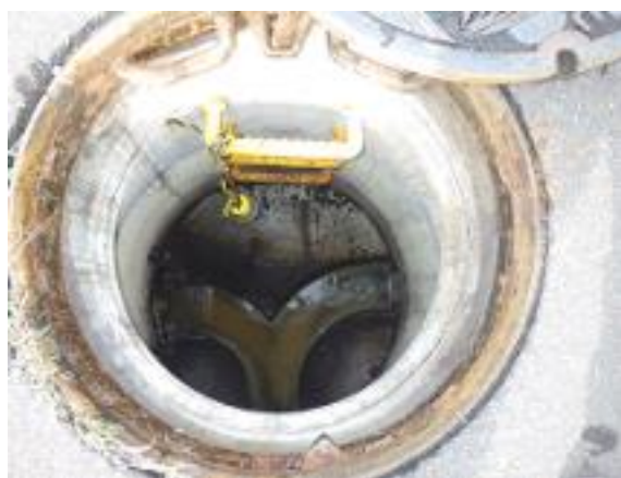
写真 2 硫化水素測定器の設置方法(例)
