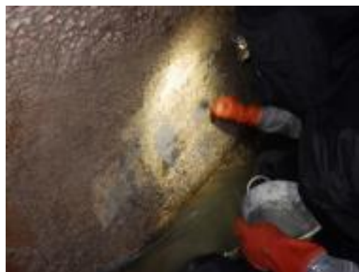
写真 6 採取跡の補修状況
