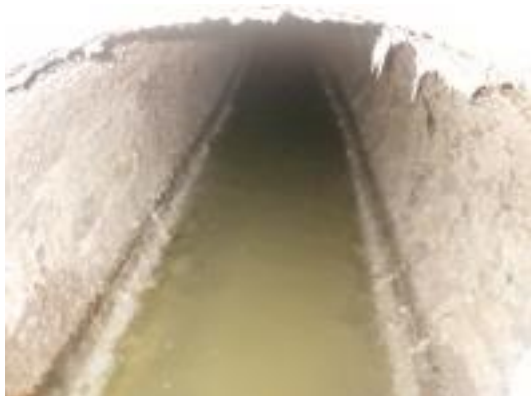
写真 3 下水道管の内面状況 (その1)
