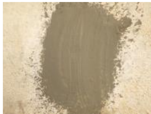
写真 6 採取跡の補修状況
