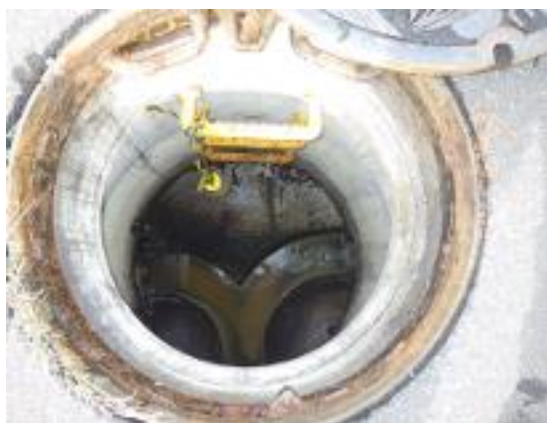
写真 2 硫化水素測定器の設置方法(例)
