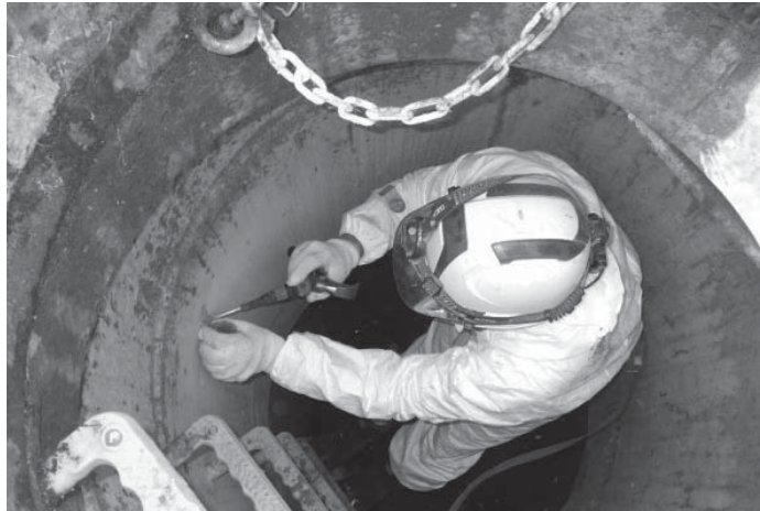
現場追跡調査も実施している
