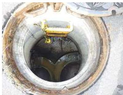
写真2-5 硫化水素濃度測定器の設置方法
