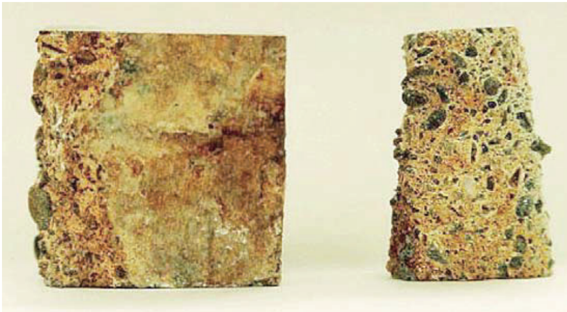
汚泥処理槽に5.5年曝露した供試体（左：ビックリート）
