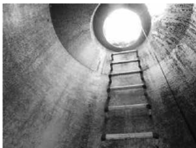
写真-1 マンホール内面
