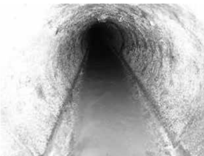
写真-2 下水道管内面
