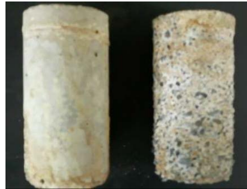
添加(-1.3%) 無添加(-13.7%) 写真-1 曝露試験供試体状況 (劣化部除去後)
