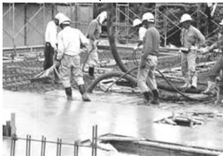
写真―4 コンクリート打設状況 (農村集落排水処理施設)
