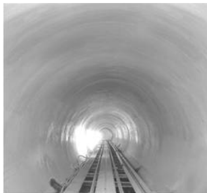
写真―5 防菌モルタル補修後 (下水管路施設)
