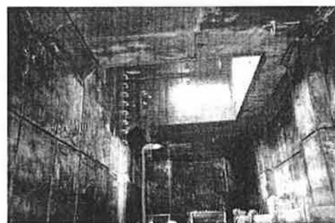
シートライニング完了
