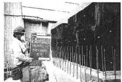
型枠工法施工
