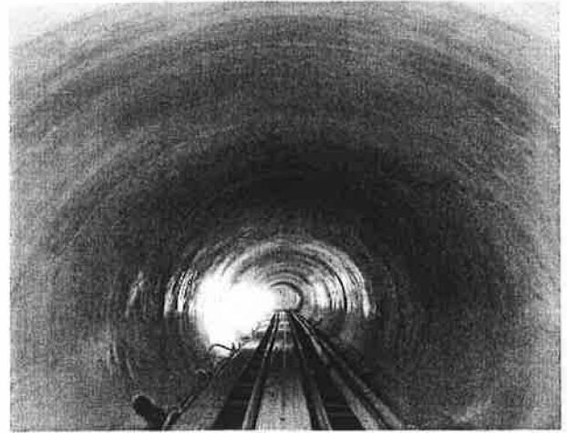
写真-2 補修完了状況
