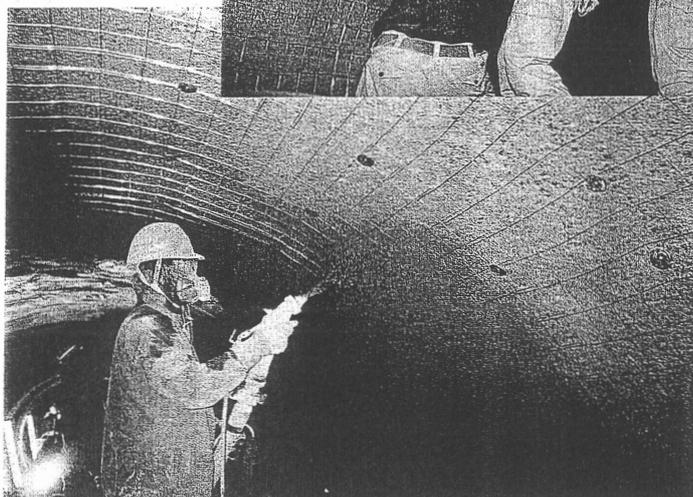
建築工事で外壁の吹き付けに用いていた機械を利用し、防菌コンクリートを吹き付けた
