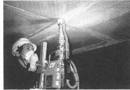
写真-2 NAPシート の現場溶接
