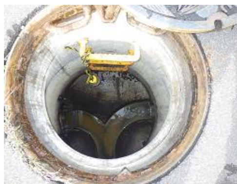
写真-5 硫化水素濃度測定器の設置方法
