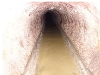
写真-2 下水道管内面
